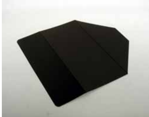
シャッターを寸法通りカットします。
